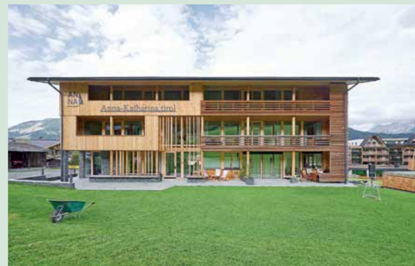
Das Appartementhaus Anna-Katharina in Fieberbrunn hat den Holzbaupreis 2023 gewonnen.
