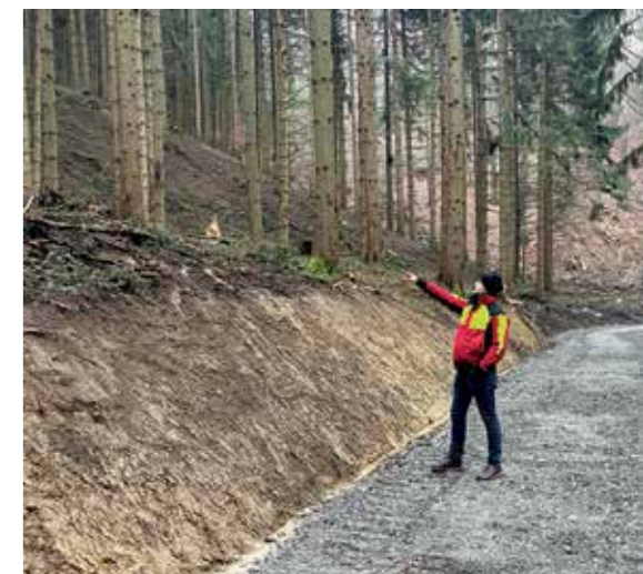
Ein Arbeitseinsatz endet bei mir nicht mit der Holzabfuhr, sondern erst dann, wenn die „Baustelle“ sauber hinterlassen ist.
