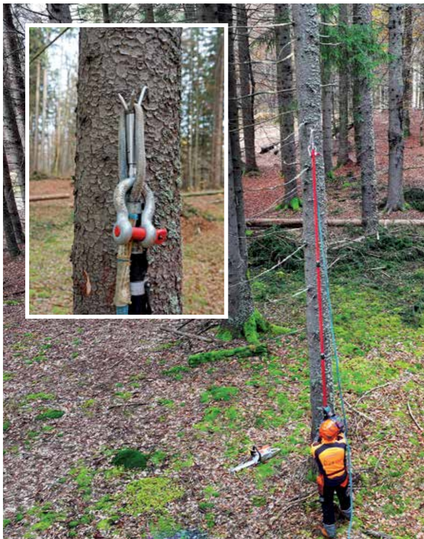
Das Hilfsseil lässt sich mithilfe einer Teleskopstange vom Boden aus in einer Höhe von über 8 Metern anschlagen.
