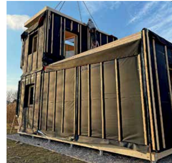
Das Demonstrationsgebäude in Tulln nach dem Wiederaufbau. Fotos (4): Woschitz Group
