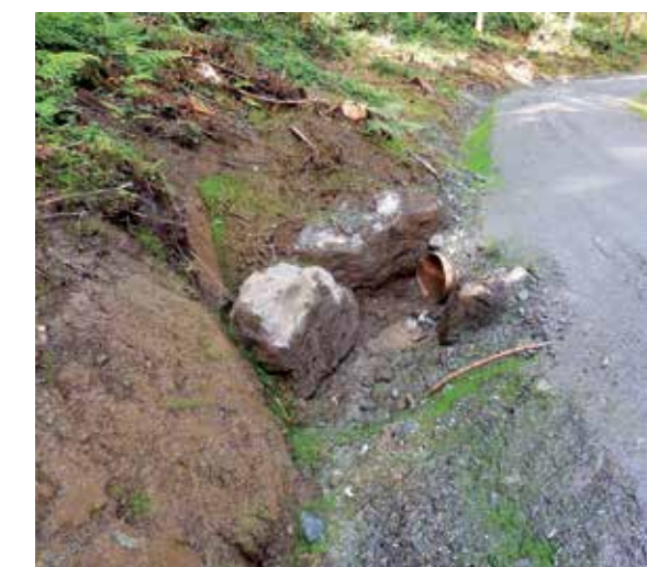
Ein ordentlich versteinter und gereinigter Rohreinlauf.
