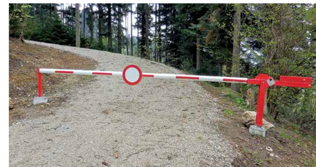
Abschranken zur Vermeidung von Schäden durch unbefugtes Befahren.
