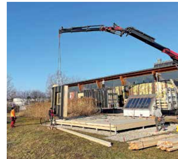
Arbeiten für den Wiederaufbau des Demonstrationsgebäudes in Tulln.
