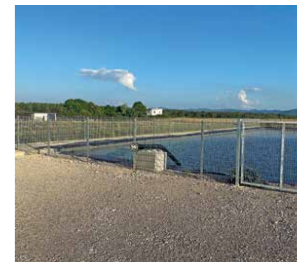
Löschwasserentnahme durch eine Steigleitung.
