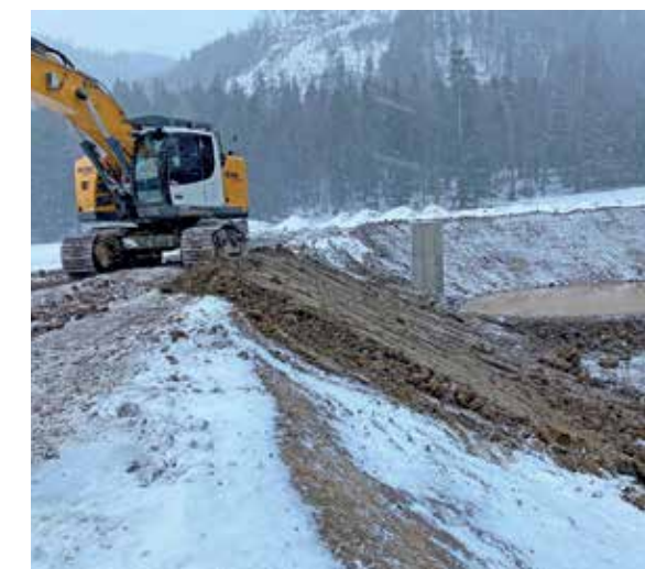
Die Errichtung eines Löschteiches mittels Lehm Schlag.
