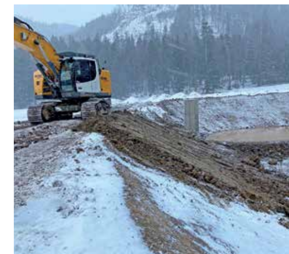
Die Errichtung eines Löschteiches mittels Lehm Schlag.
