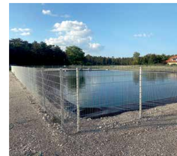
Die Errichtung eines Löschteiches mit einer Teichfolie.
