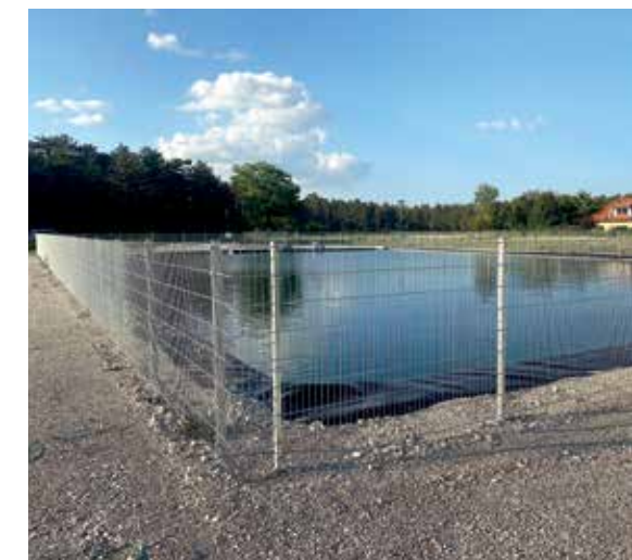
Die Errichtung eines Löschteiches mit einer Teichfolie.
