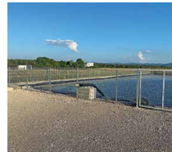
Löschwasserentnahme durch eine Steigleitung.
