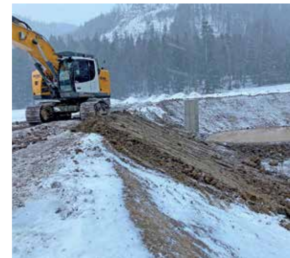
Die Errichtung eines Löschteiches mittels Lehm Schlag.
