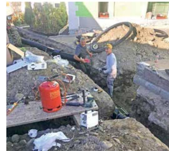
In Summe wurden 1.200 Meter Kunststoffleitungen (Doppelrohrsystem) verlegt.
