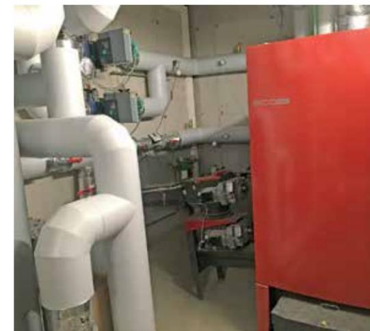
Ein Heizkessel mit Verrohrung der Pufferspeicher, im Hintergrund die Netzpumpen.
