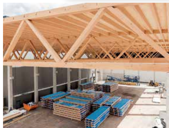
Lagerhallenüberdachung aus Buchen-Furnierschichtholz der Firma Pollmeier.
