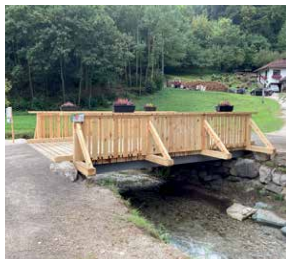
Die Burschen und Mädels in Furth/Triesting errichteten eine neue Brücke.
