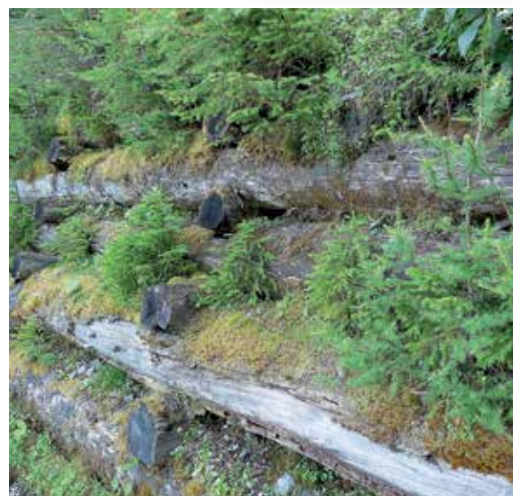
Strukturreiche Oberböschung auf Holzkrainerwand.
