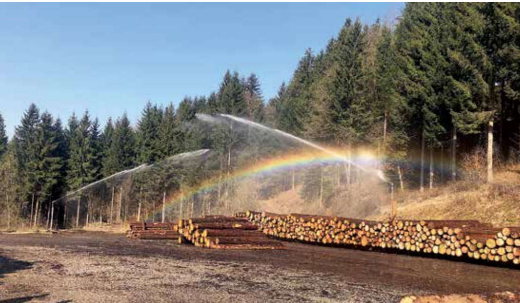
In Osttirol werden zur Zeit zwei große Nasslager errichtet.
