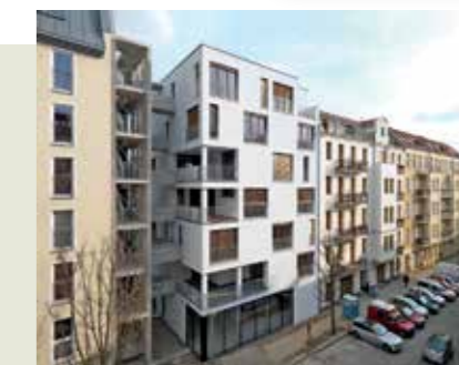
Das Projekt e3 wurde auf einem Grundstück in der Berliner Esmarchstraße realisiert. Es handelt sich hierbei um die erste siebengeschossige Holzkonstruktion in einem großstädtischen Zentrumsbereich Europas. Foto: kadendpartner
