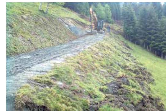
Möglich und wünschenswert bei Böschungen ist auch das Einsetzen von Vegetationssoden. Mit dem Bagger werden vorne Rasenziegel vorsichtig herausgenommen und rückwärts wieder eingesetzt. Dadurch entstehen Forstwege, die sich sofort harmonisch in das bestehende Gelände einfügen.
