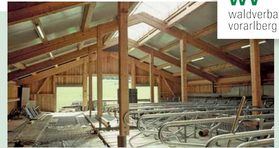
Borkenkäfer- oder Windwurfholz lassen sich uneingeschränkt für verschiedene Bauvorhaben verwenden. Die „Verblauung“ stellt nur einen optischen Schaden dar, der im Bauholz nach einer kurzen Zeit kaum mehr sichtbar ist. Foto: LK Vorarlberg
