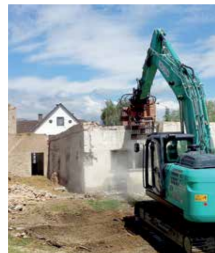
Abriss- und Entsorgungskosten darf man nicht unterschätzen.
