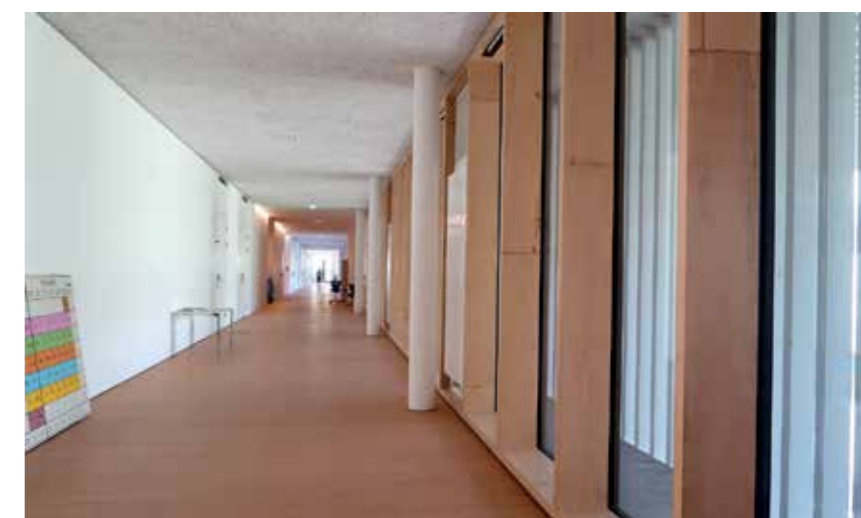
Bei dem innovativen Projekt „Schule am See“ wurde die Buche in dieser Form für Boden, Möbel und Fassadenelemente gezielt eingesetzt.
