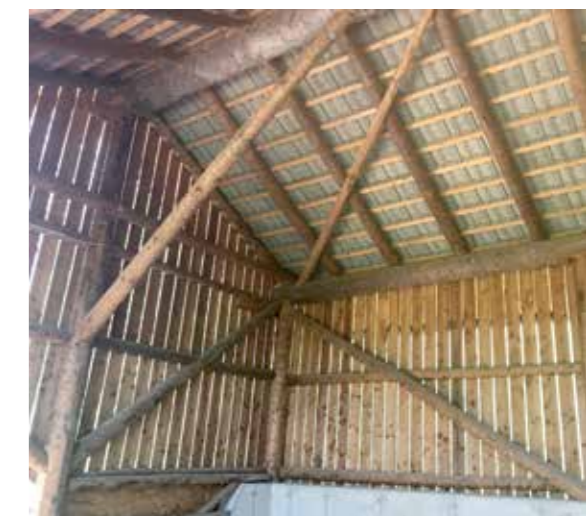
Die Rundholzkonstruktionen wurden anschließend mit Lärchenbrettern verschalt.
