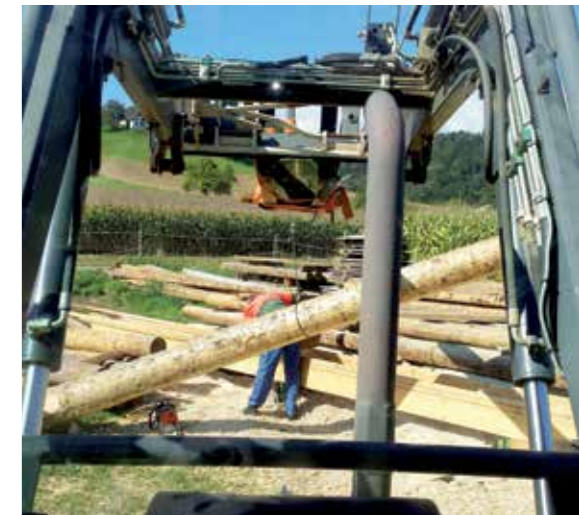
Am Lagerplatz wurden die Stämme vorbearbeitet, beschriftet und sortiert.
