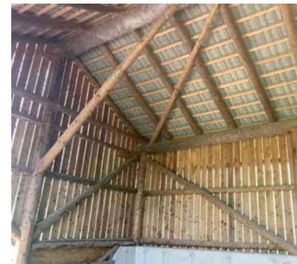
Die Rundholzkonstruktionen wurden anschließend mit Lärchenbrettern verschalt.
