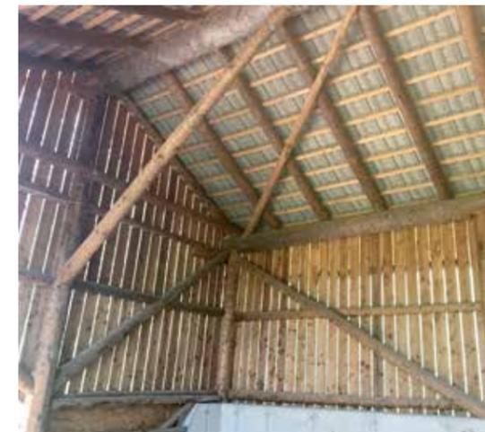
Die Rundholzkonstruktionen wurden anschließend mit Lärchenbrettern verschalt.
