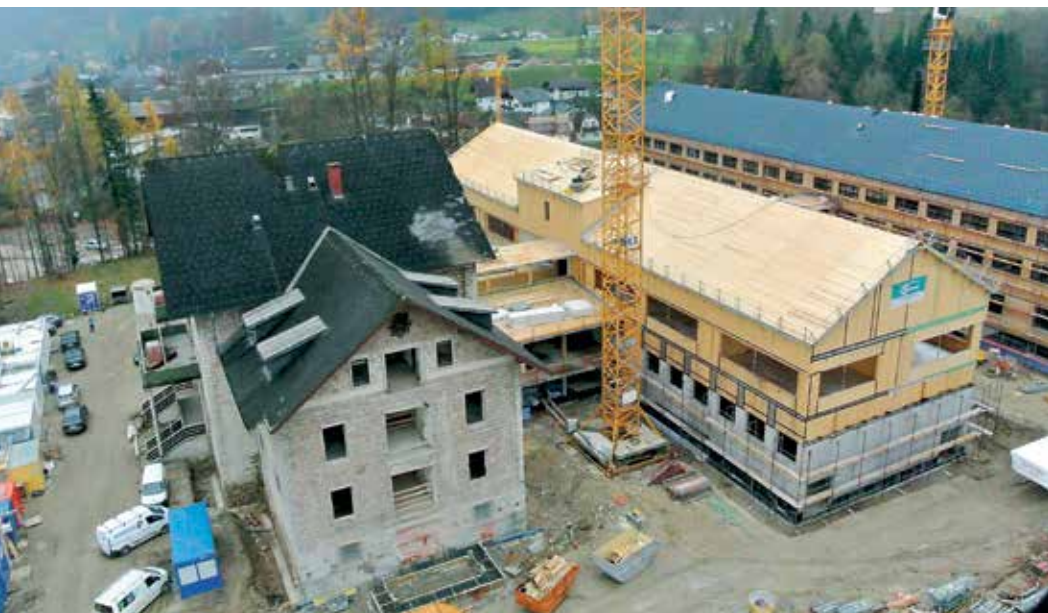
Holz spielt beim Neubau des Kompetenzzentrums eine große Rolle.
