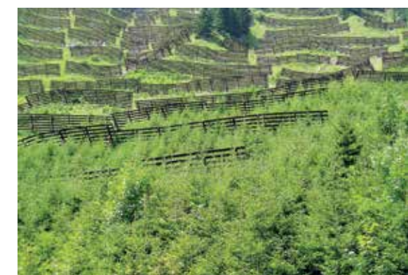
Auf den obigen Bildern ist sehr gut zu erkennen, wie durch technische Schutzmaßnahmen Auf- forstungserfolge erzielt werden können.
