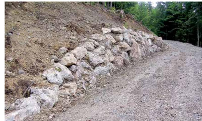
Die Böschungsbefestigung erfolgt bergseitig in der Regel in Form einer Grobsteinschichtung. Krainerwände und Holzkästen haben ausgedient.
