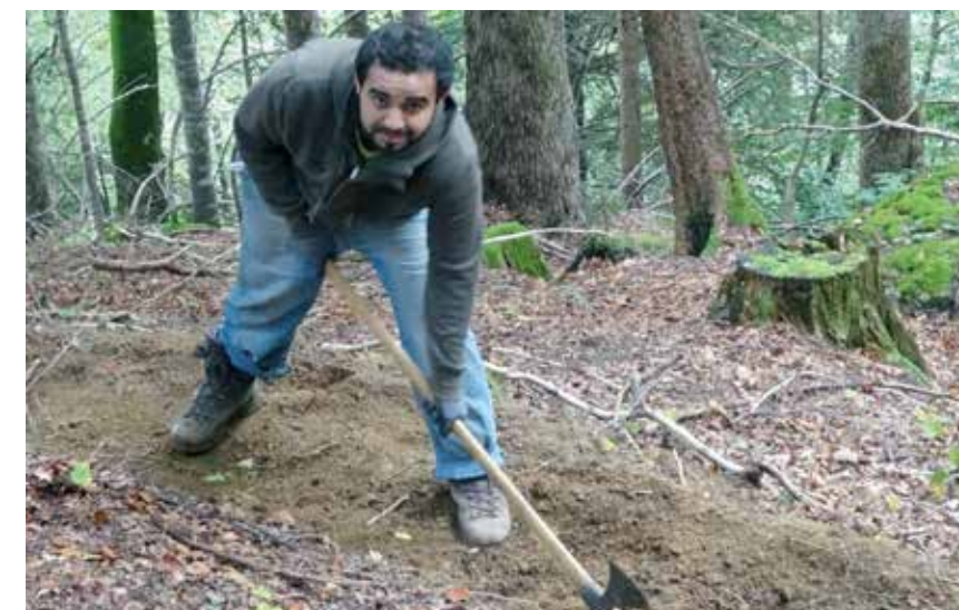
Flüchtlinge machen sich im Gastland im Wald nützlich. Hier wird gerade ein Begehungssteig errichtet.
