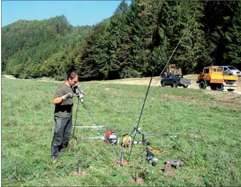
Der patentierte Bodenanker „Spinnanker“ der Firma Oberhofer kann schnell und problemlos im Boden verankert werden.
